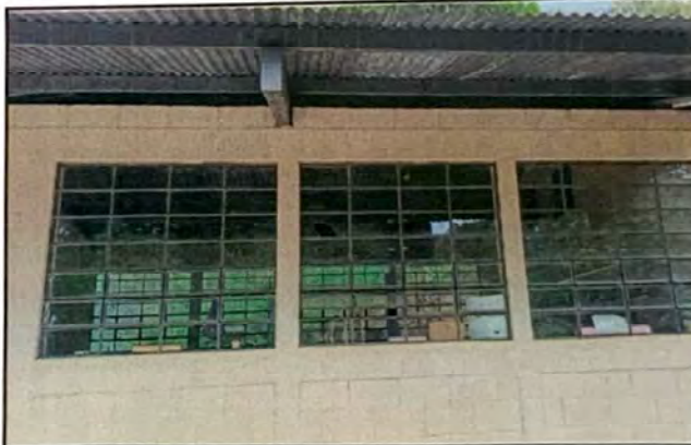
Foto 4: Reparación de ventanas.
