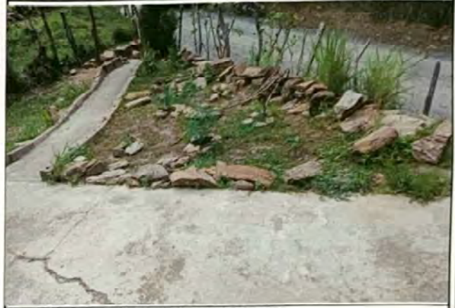
Foto 6: Losa de patio, banquetas y entortado.
