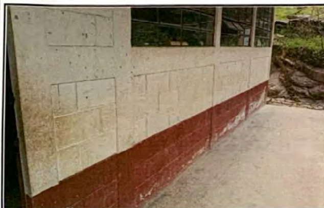
Foto 3: Pintura de muros interior y exterior.
