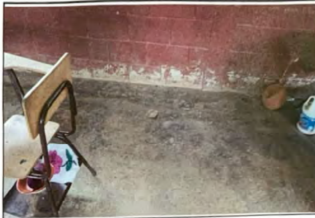
Foto 2: Reparación de piso.
