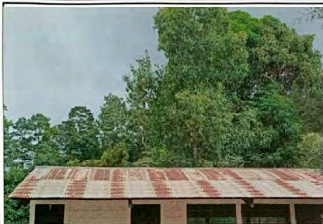
Foto 1: Cambio de lámina y estructura de techo.
