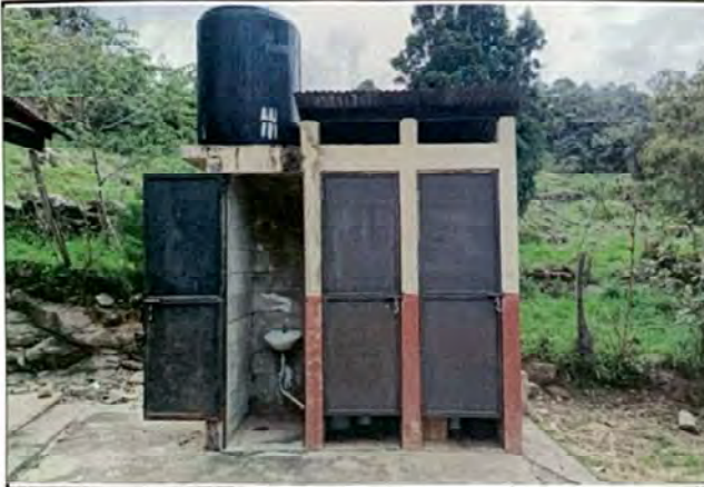
Foto 5: Reparación de servicios sanitarios y accesorios, lava manos, Rotoplast y Tubería PVC
